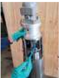
拧紧水泵固定螺钉
